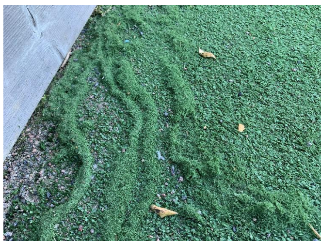
Figur 18. Omfattande fibersläpp från konstgräsyta K4.
