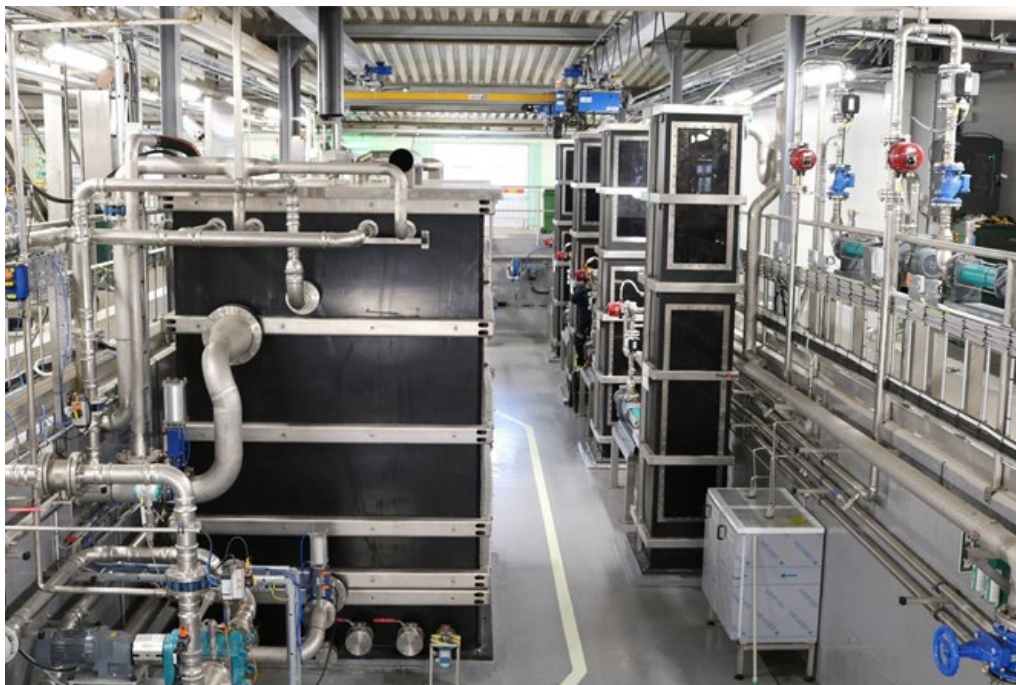
Figur 22. MBR-GAK-pilotanläggningen med membrantankar till vänster och de fyra GAK-filtren till höger.
